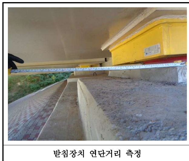
【사진 5.3.14】 교량받침장치 연단거리측정
