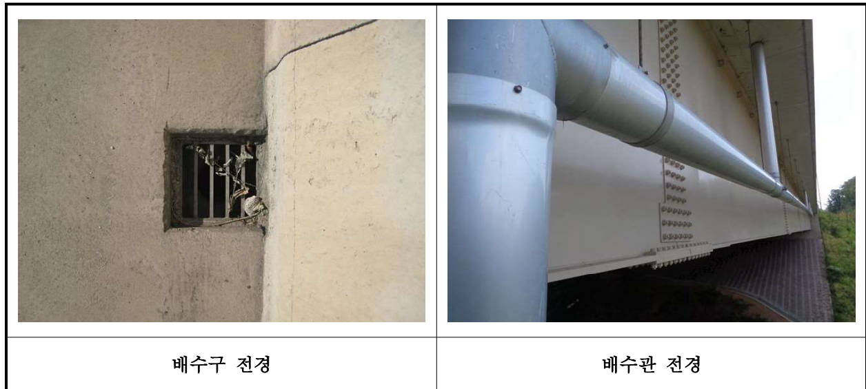
【사진 5.3.21】 배수시설 전경
