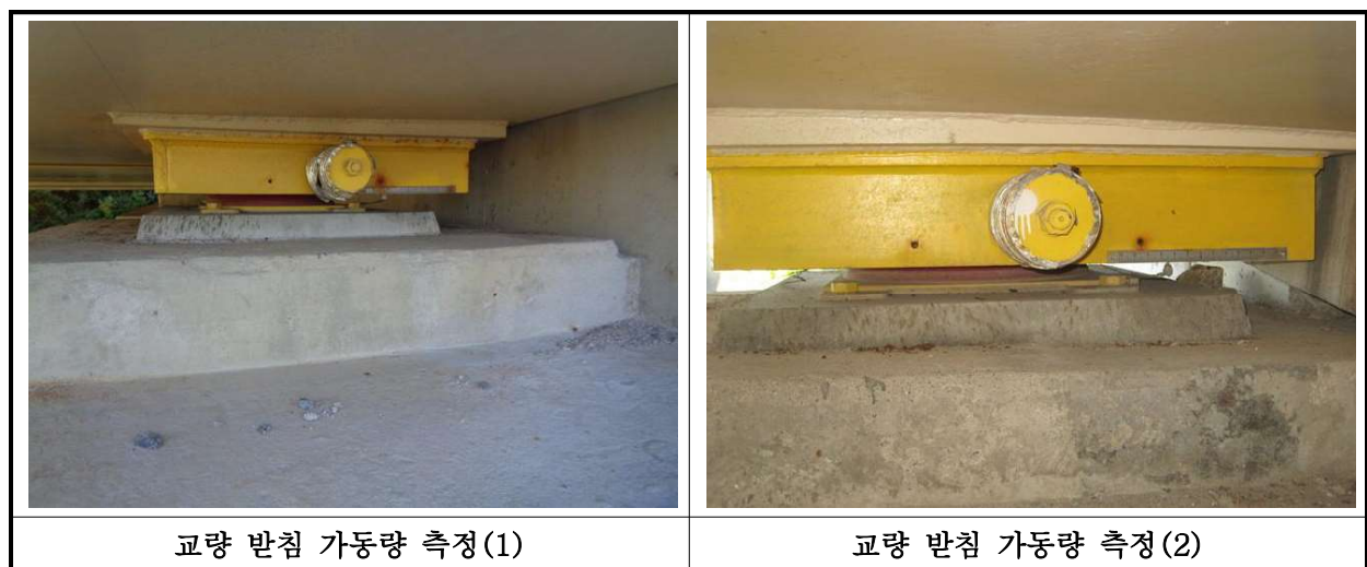
【사진 5.3.15】교량받침 이동량 측정
