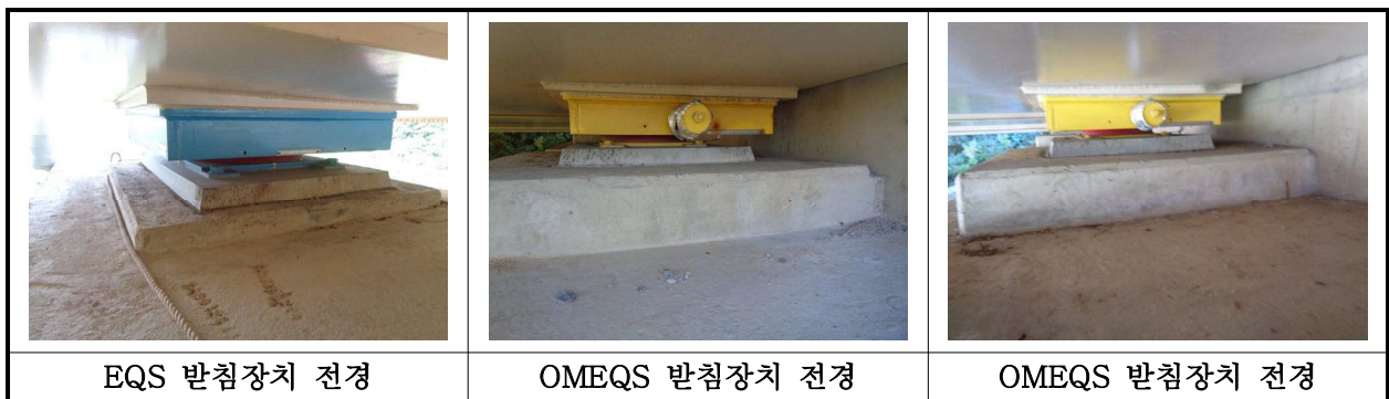
【사진 5.3.12】 교량받침 전경
