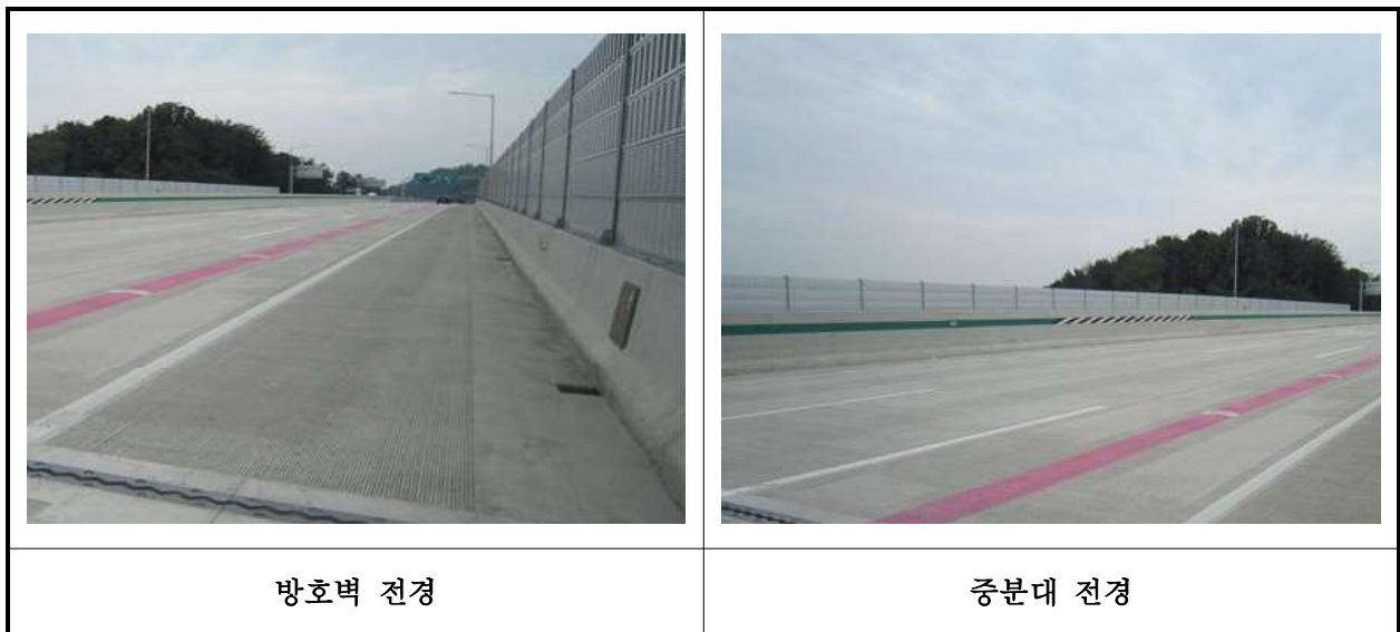
【사진 5.3.23】 방호벽 및 중앙분리대 전경
