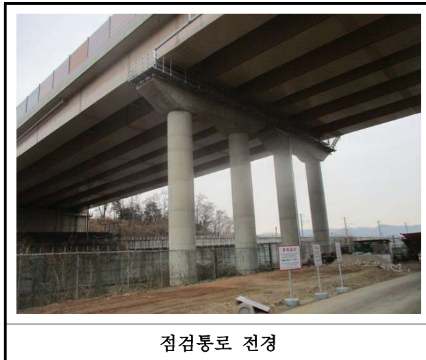
【사진 5.3.25】 교량 점검시설 전경
