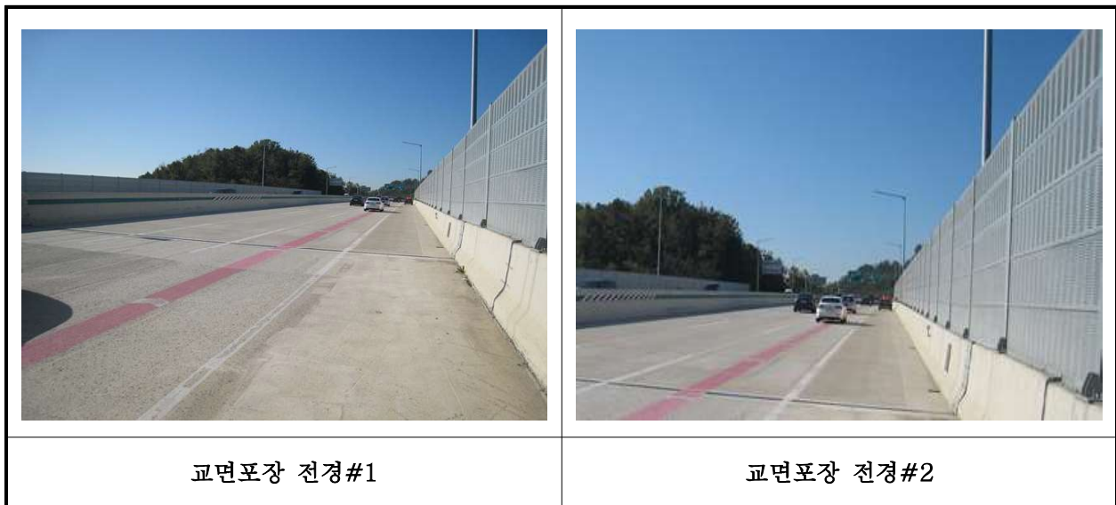
【사진 5.3.19】 교면포장 전경
