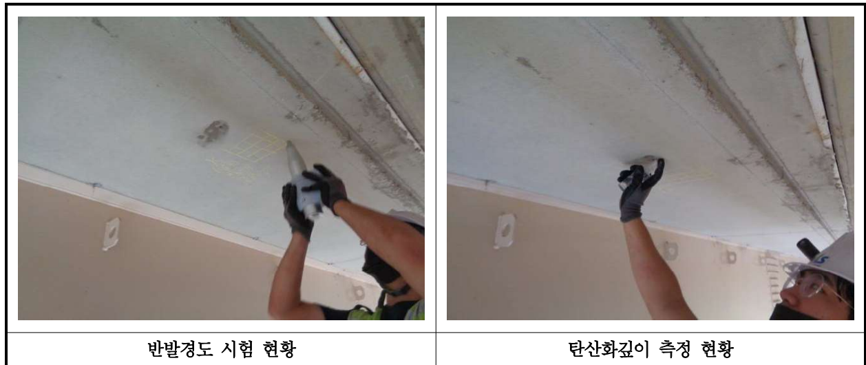
【사진 5.4.1】 콘크리트 내구성조사 현황
